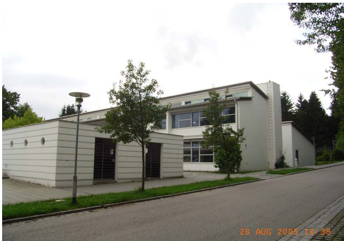
Foto: Blick auf den Messpunkt
