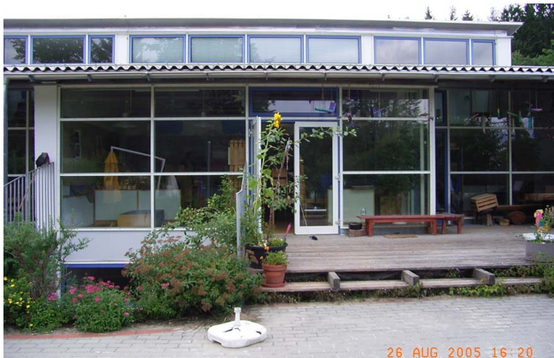
Foto: Blick auf den Messpunkt
