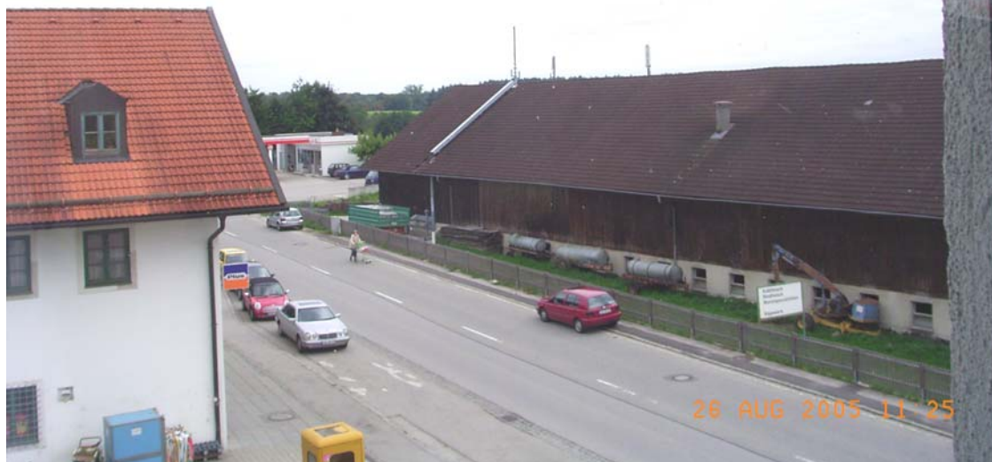
Foto: Blick vom Messpunkt auf die Sendeanlage
