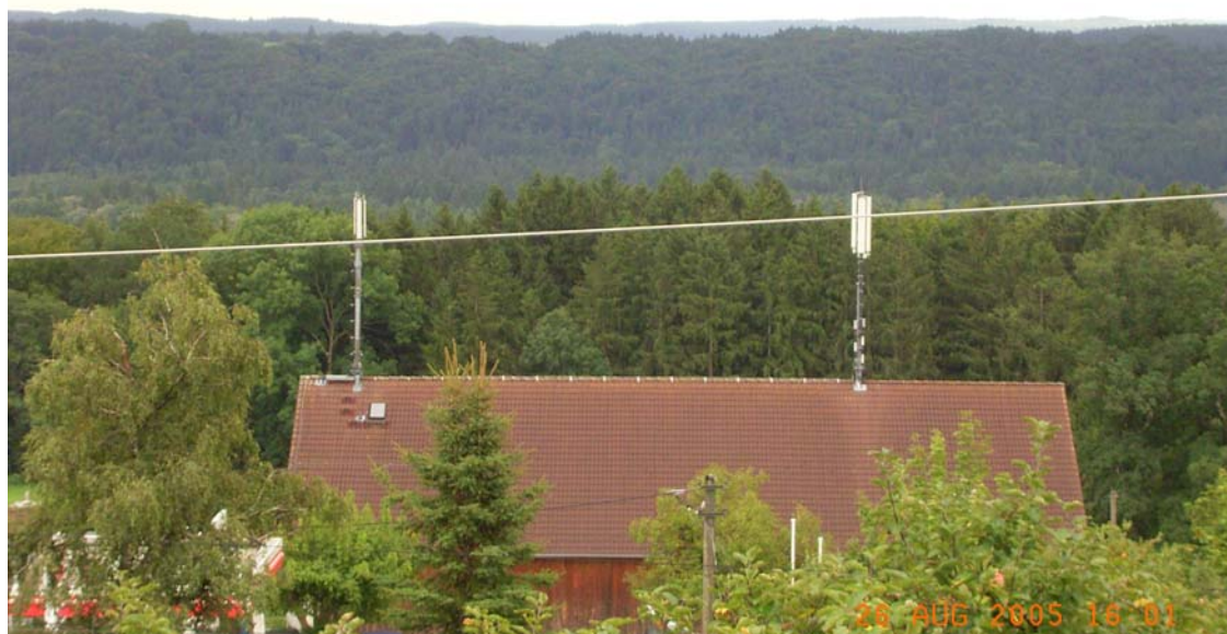
Foto: Blick vom Messpunkt auf die Sendeanlage
