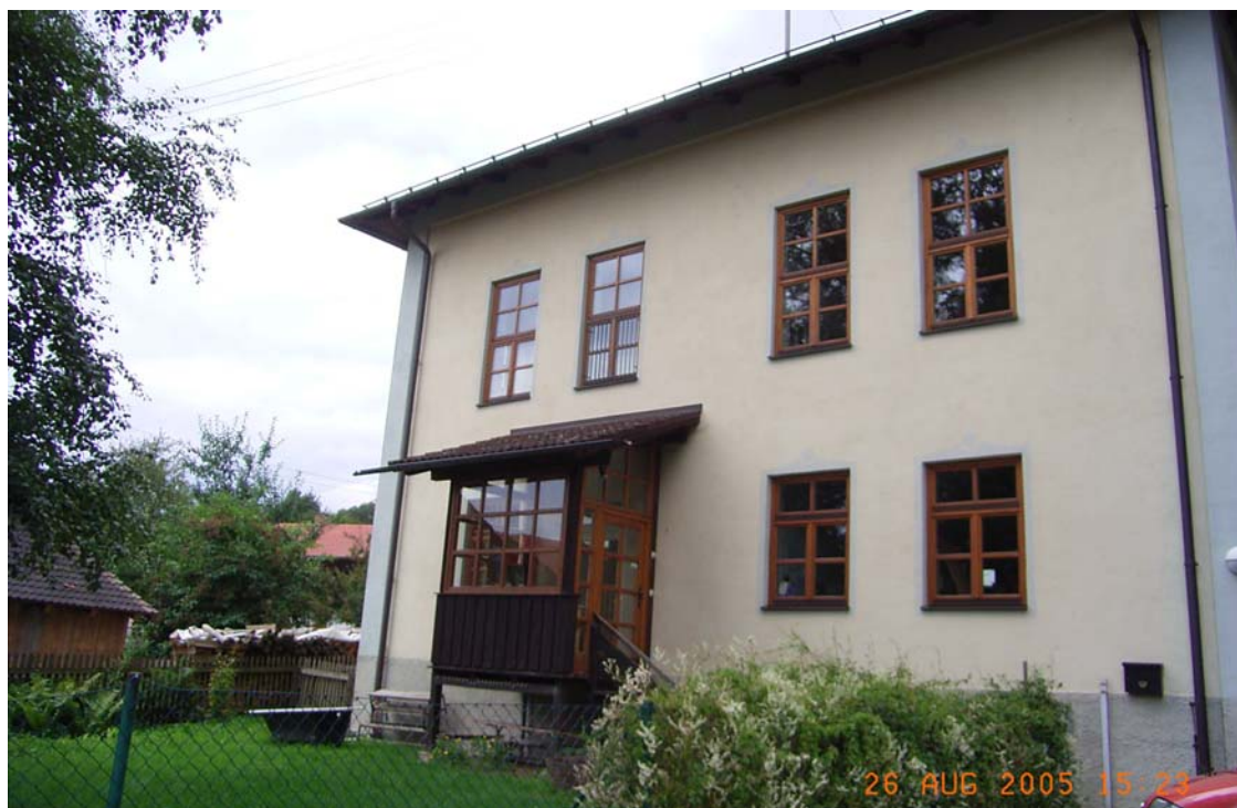
Foto: Blick auf den Messpunkt
