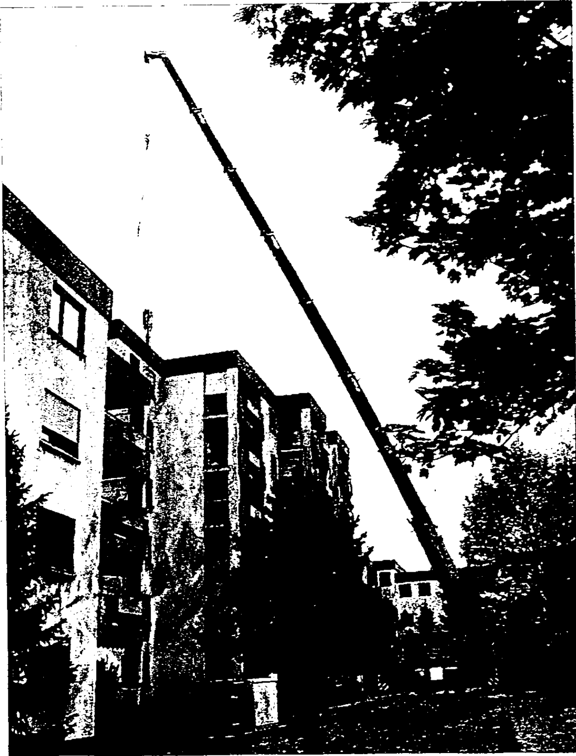
Mit einem Autokran ist eine der umstrittenen Mobilfunkantennen vom Dach eines Wohnhauses an der Machern-Straße gehievt worden. Foto: Diel
